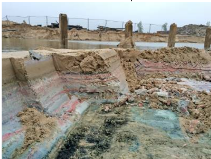
Figuur 11-2. Asbest vloeiveld
