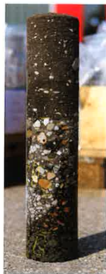
Foto 6. Boren tot aan de onderzijde van het asfalt
