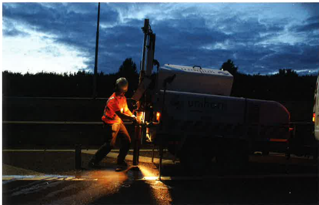
Foto 2. Boren van asfaltkernen
