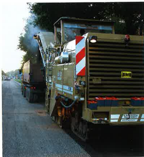
Foto 3. Frezen van asfalt
