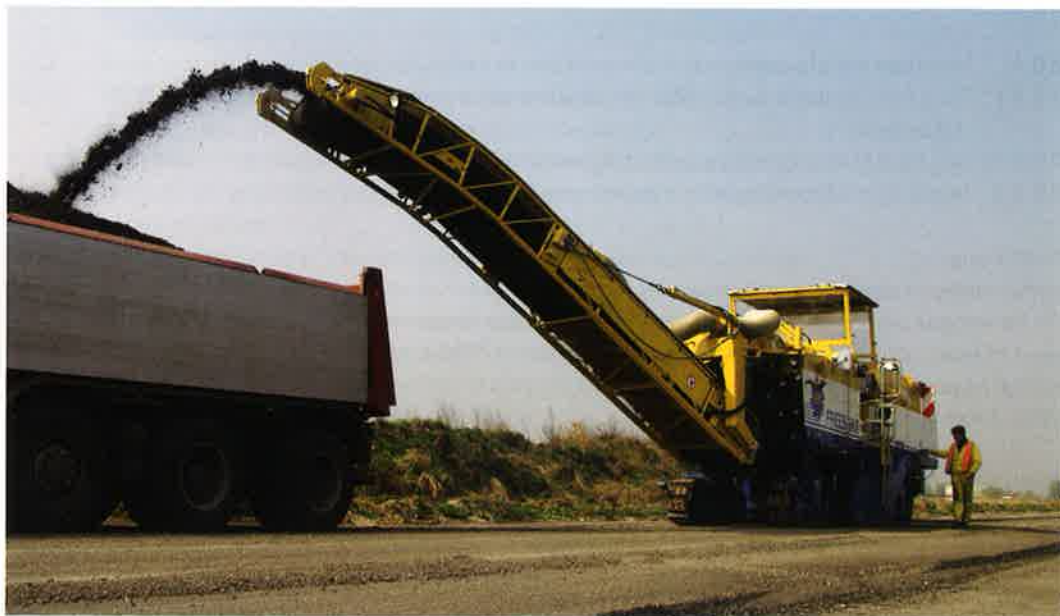
Foto 10. Selectief verwijderen van asfalt
