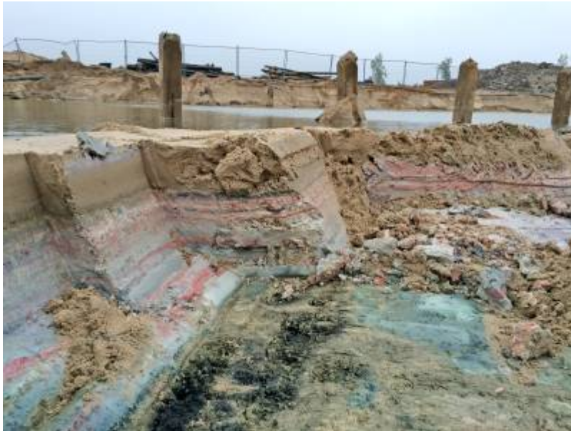
Figuur 11-2. Asbest vloeiveld
