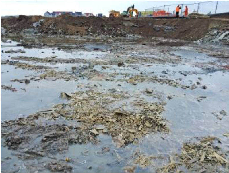
Figuur 11-1. Asbest in bodem
